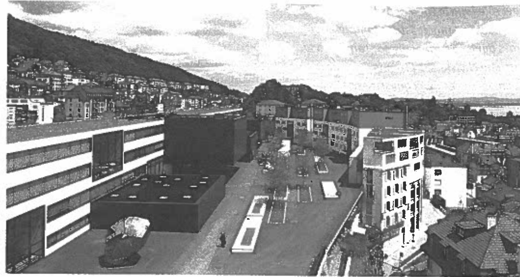
Le nouvel auditorium du campus Arc1 est construit en porte-à-faux, ancré dans la façade sans aucun appui latéral.
